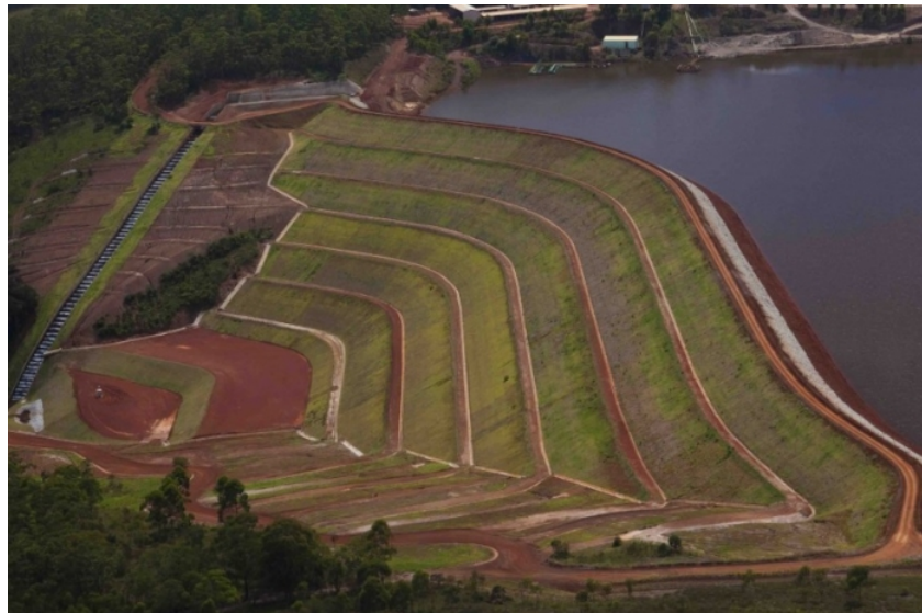
Barragem Maravilha II, em Itabirito (MG)
