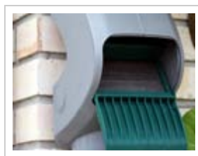
Dispositivo de descarte de sólidos instalado na tubulação de água pluvial. Clique na imagem para ampliar
