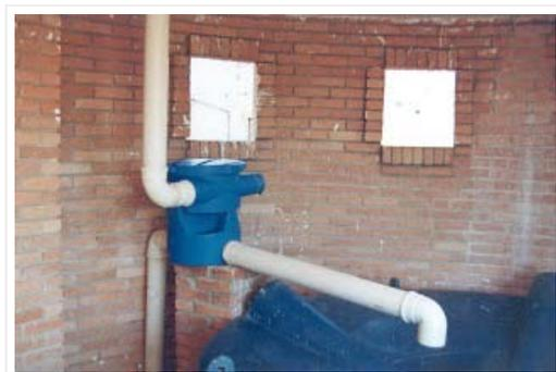
Um sistema de água da chuva requer a captação pelas calhas, a filtragem e o armazenamento. Dependendo da dimensão e da especificação dos equipamentos, um sistema de aproveitamento de água da chuva
